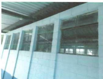
Foto1: Sustrución de ventanas; sistema de apertura: Corredizas, Perfiles color blanco estandar, Material del marco: PVC Material de la ventana: Vidrio, sellado perimetral.
