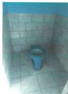
Foto 2: Sustrución de sanitarios, por sanitarios lavables, accesorios y conexiones.
